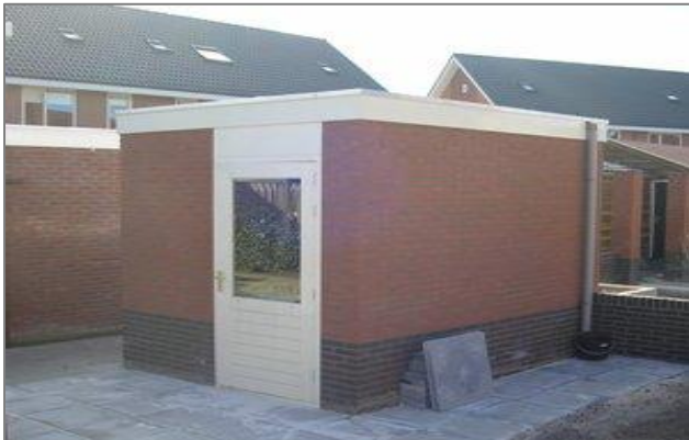
Voorbeeld van een vrijstaande stenen berging
